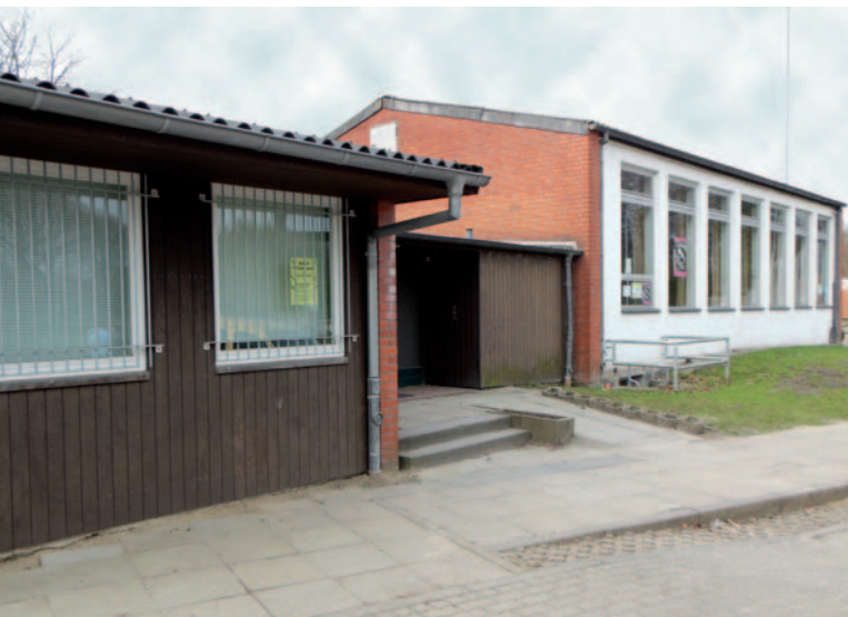
Die ehemalige MZH, jetzt Peter-Frensch-Halle. Wenig Auslastung – Hohe Unterhaltskosten!
